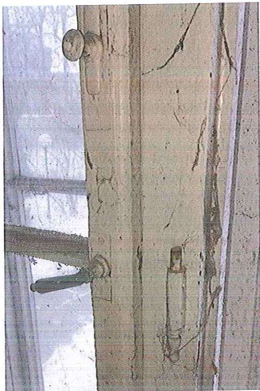
Fot. 20. Okucia okna oznaczonego I 04. Pokryte warstwami farb: zawias, odbojnik i część mosiężnej klamki. Brak górnego czopu w zawiasie, widoczna w tym miejscu rdza. Budynek „Kossakówka, Pl. Kossaka 4, Kraków. Fot. D. Narowska Avonza, luty 2021.
