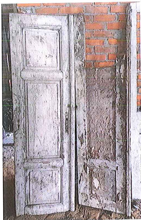
Fot. 28. Widok stolarki drzwiowej, oznaczonej: D(d), elementy dwuskrzydłowych drzwi płycinowych, wewnętrznych, magazynowane w budynku w nieodpowiednich warunkach przez nieokreślony czas. Fatalny stan zachowania. Obecnie przechowywane w magazynie MOCAK. Budynek „Kossakówka, Pl. Kossaka 4, Kraków. Fot. D. Narowska Avonza, wrzesień 2021
