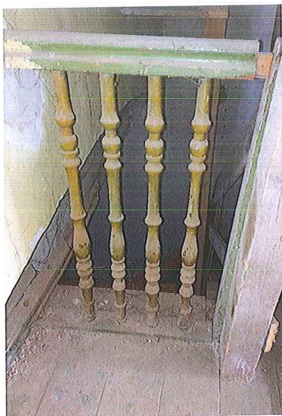
Fot. 35. Drewniana balustrada z pochwytym i słupkiem, jedyny zachowany fragment. Widoczne nawarstwienia malarskie oraz rozejście się połączenia pochwytu ze słupkiem. Budynek „Kossakówka, Pl. Kossaka 4, Kraków. Fot. D. Narowska Avonza, luty 2021.
