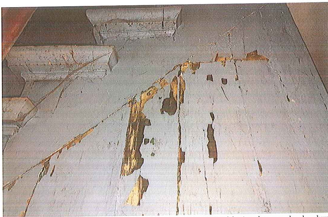
Fot. 34. Widok drewnianych schodów, rozległe ubytki warstwy malarskiej, odłonięte drewno w bardzo złym stanie, zaatakowane zgnilizną brunatną. Budynek „Kossakówka, Pl. Kossaka 4, Kraków. D. Narowska Avonza, luty 2021.
