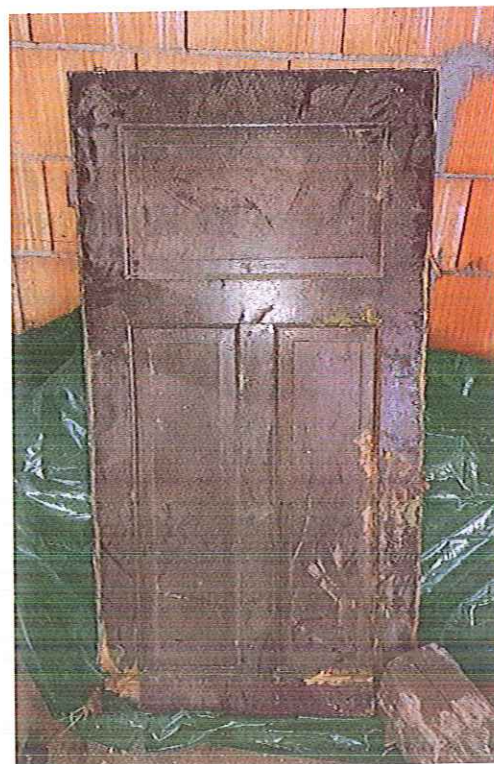
Fot. 31. Widok stolarki drzwiowej, oznaczonej: D(e), skrzydło jednoskrzydłowych drzwi płycinowych, wewnętrznych. Zły stan zachowania, spowodowany niewłaściwym przechowywaniem. Obecnie przechowywane w magazynie MOCAK. Budynek „Kossakówka, Pl. Kossaka 4, Kraków. Fot. D. Narowska Avonza, wrzesień 2021
