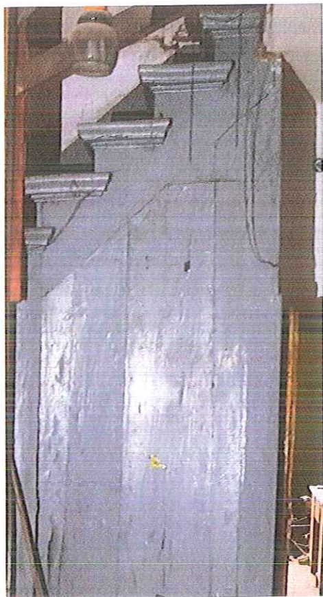
Fot. 32. Widok drewnianych schodów, powłoka malarska w kilku miejscach spękana, niewielkie ubytki – świadczące o postępującym procesie destrukcji drewna zachodzącej pod warstwami farby. Budynek „Kossakówka, Pl. Kossaka 4, Kraków . Fot. z archiwum MOCAK, wykonana w styczniu 2020.
