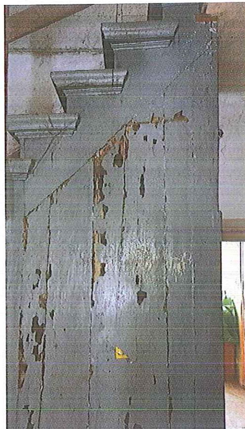
Fot. 33. Widok drewnianych schodów, liczne i rozległe ubytki warstwy malarskiej, odsłonięte drewno w bardzo złym stanie, zaatakowane zgnilizną brunatną. Budynek „Kossakówka, Pl. Kossaka 4, Kraków . Fot. D. Narowska Avonza, luty 2021.
