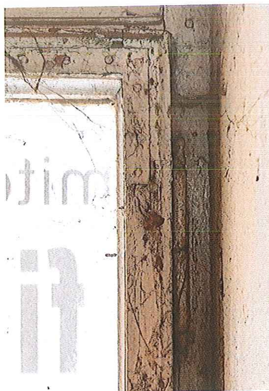
Fot. 23. Elementy okucia okna oznaczonego I 03. Pokryte warstwami farb: historyczny zawias czopowy, oraz wzmocnienie łączenia ramiaków z blaszki kątowej. Budynek „Kossakówka, Pl. Kossaka 4, Kraków. Fot. D. Narowska Avonza, luty 2021
